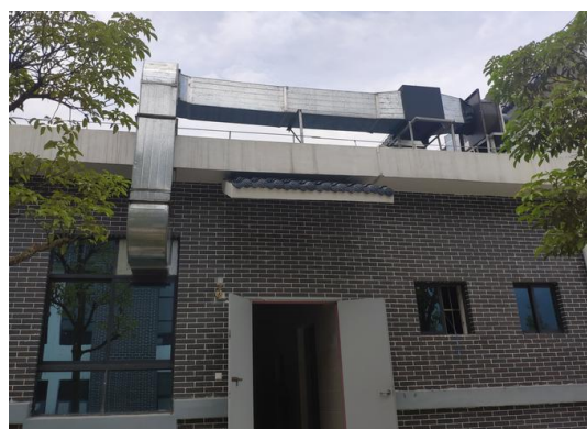
服务设施已安装的油烟净化设备及排放现状
